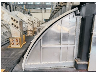
图 1 电解槽侧壁现状
