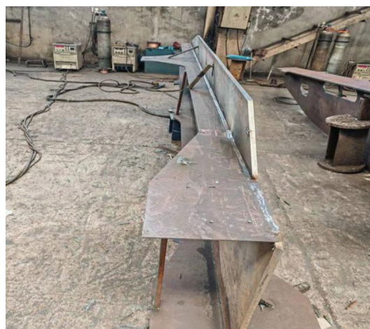
(b) 腹板、翼板、纵筋组件焊接完成
