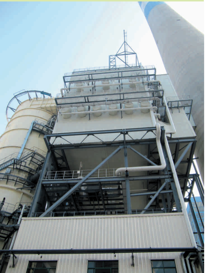
江苏徐州华美热电二期2×350MW超临界循环流化床机组采用东方电气研制的湿式静电除尘器
