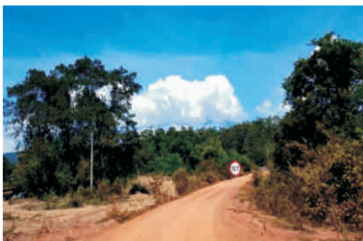
修复后的道路
