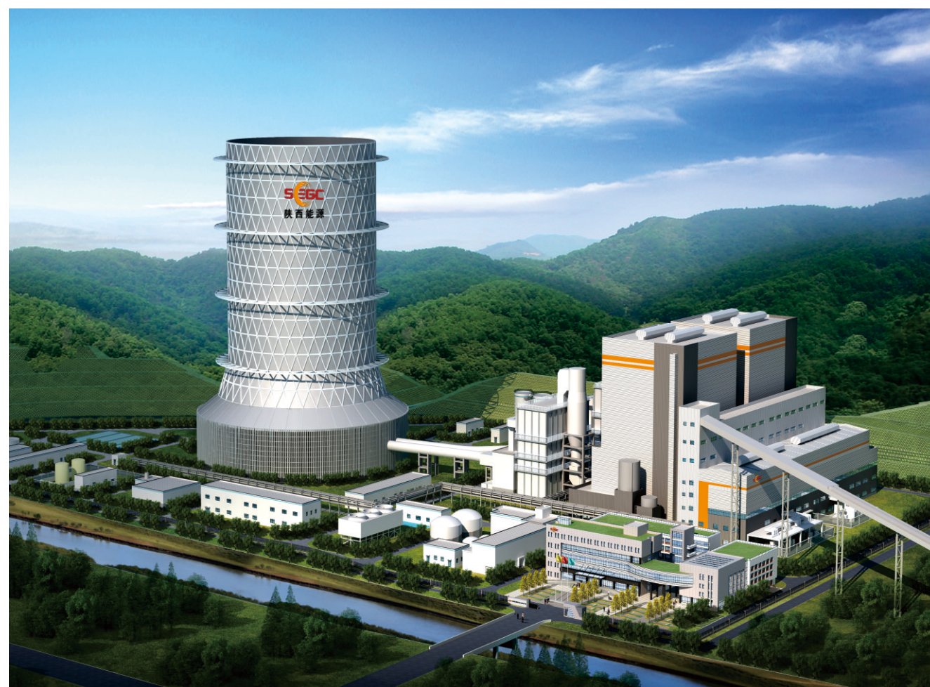
陕能麟游循环流化床机组脱硫、脱硝、除尘一体化项目
