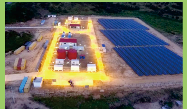
安哥拉柴光互补分布式发电总承包项目完成了8个站的建设
