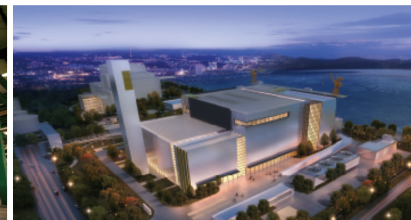
常熟浦发垃圾焚烧余热锅炉项目
