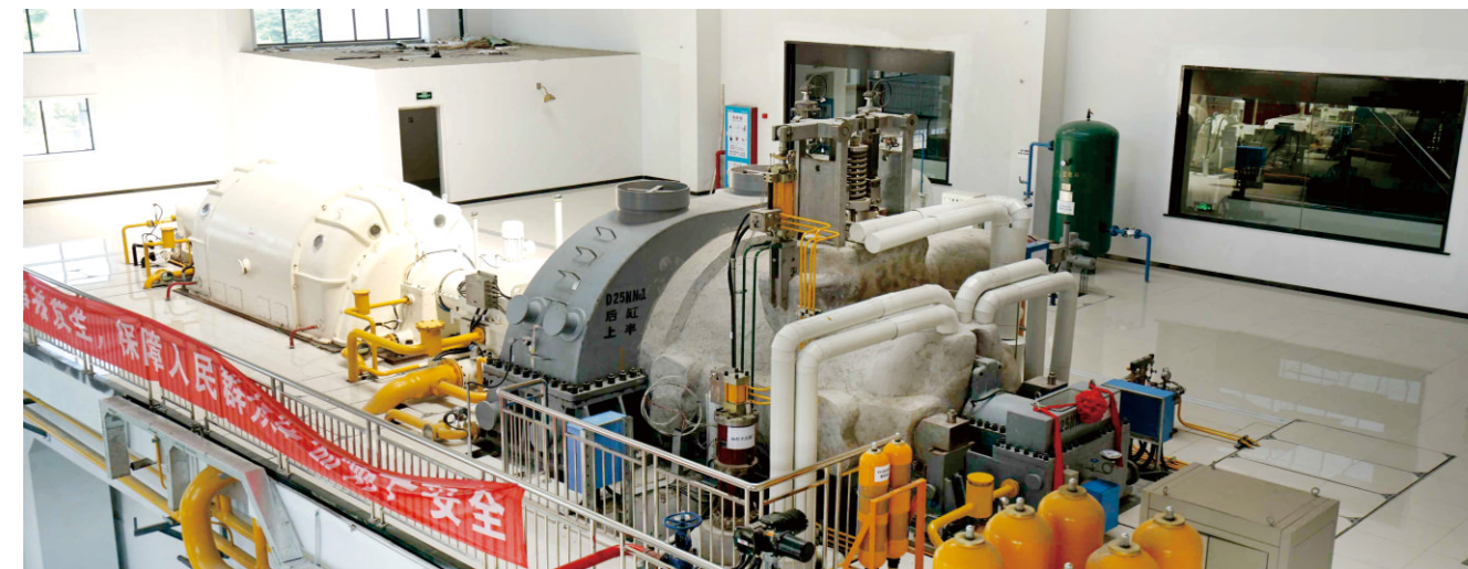
光大环保能源（江阴）有限公司三期垃圾焚烧发电项目
