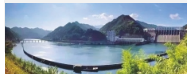
湖南柘溪水电厂外景全貌
