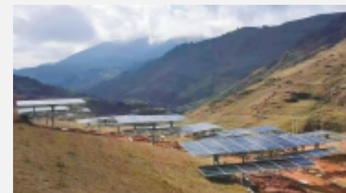
▶ 村级光伏扶贫电站
