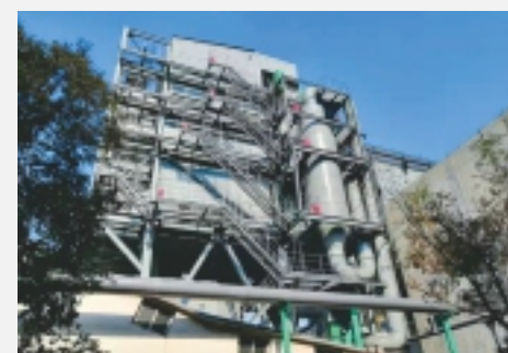
► 湖北新冶钢焦化炉SDS干法脱硫除尘、SCR脱硝项目
