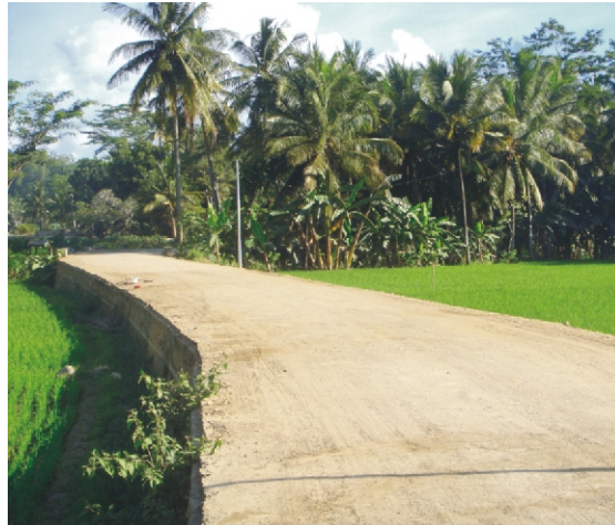
为村民铺设的混凝土道路
